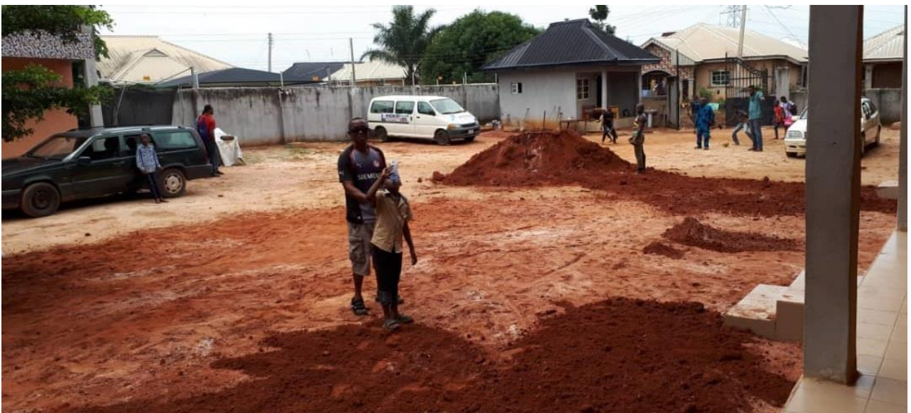
Eine Momentaufnahme der Reparatur des zuvor komplett überschwemmten Hofes. Nun hat der Hof eine Steigung, dass das Wasser bei einem ähnlichen Vorfall abfließen kann.
