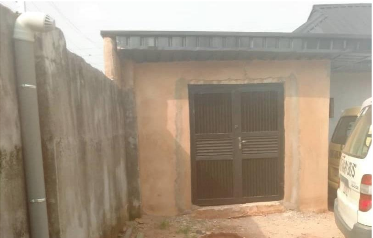
Die Klinik fast fertig. Die Elektroarbeiten sowie die Feinarbeit stehen noch aus.
