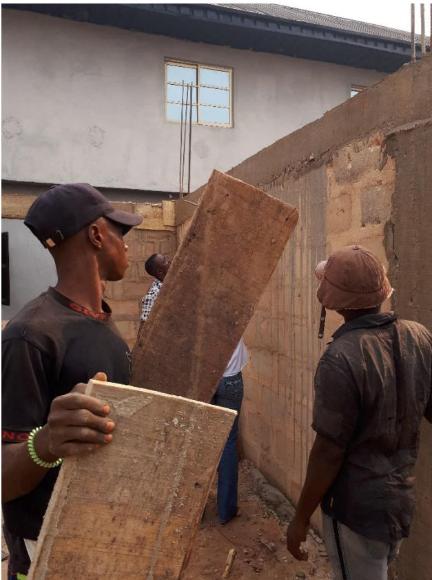
Arbeiten am Internat im Oktober. Die Schule im Hintergrund.
