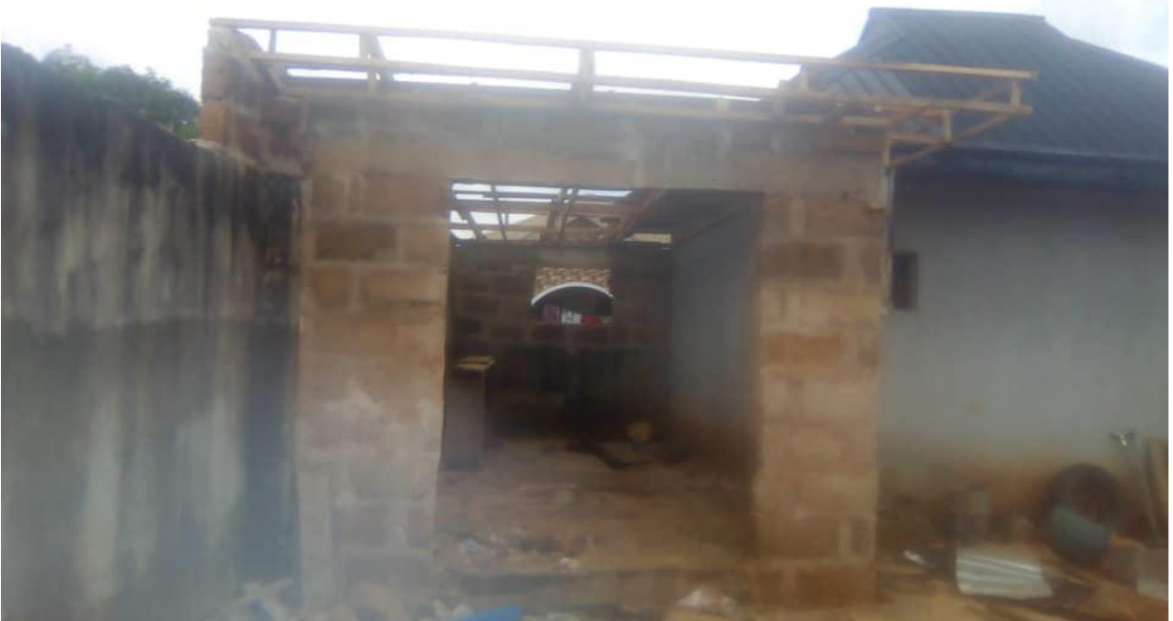
Die Klinik im Rohbau.
